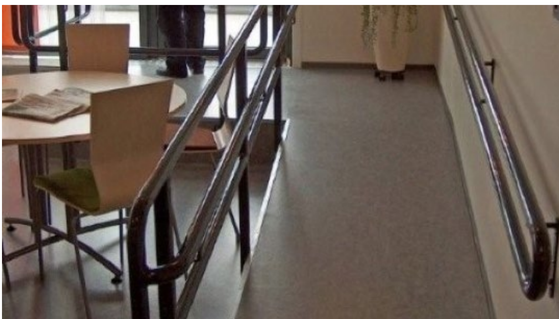
Будівля Норвезької адміністрації праці та соціального забезпечення, Брумундал, Норвегія → goo.gl/VoHd97
