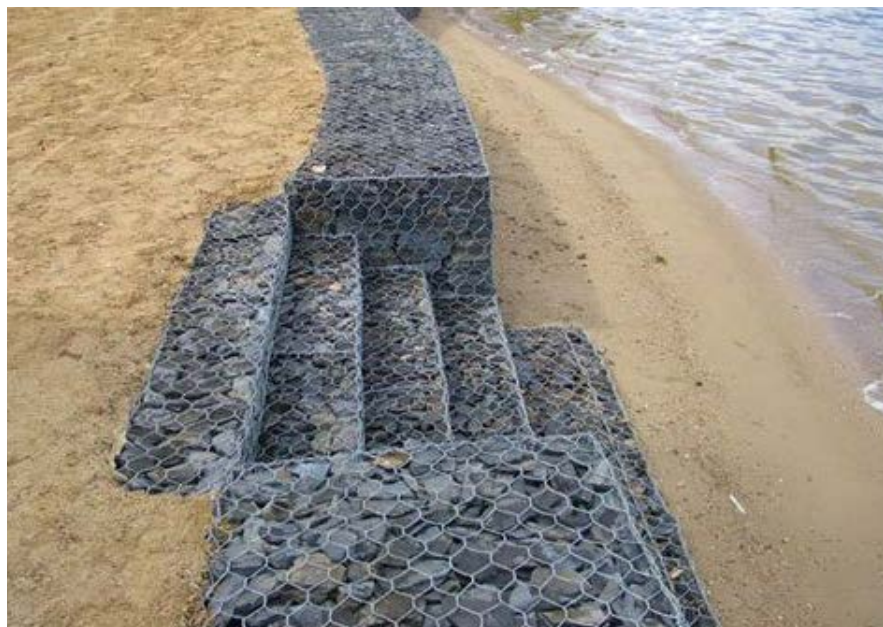
Металева сітка використовується для укріплення берегової лінії. Джерело: vashdom.ru/articles/sovremennye-metodiki-beregoukrepleniya
