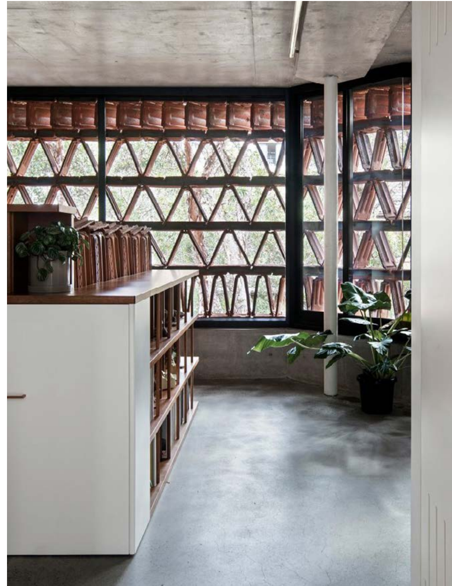
Фасад з черепичних модулів забезпечує затіненість приміщень. Джерело: luigirosselli.com/public-commercial/workspaces/bee hive
