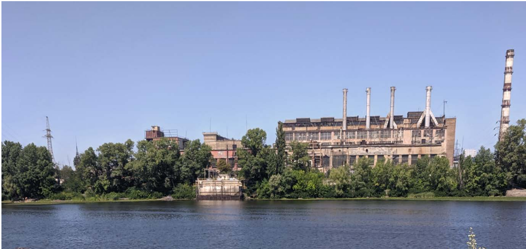
Вид на Станцію тепlopостачання №2 з території промзони
