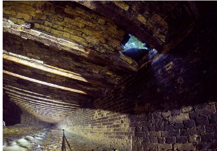
Поломка колектора Глибочиці ізсередини. Джерело: instagram.com/theodosos
