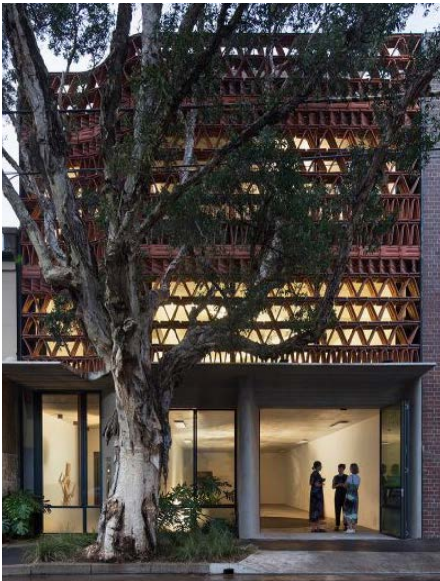
Фасад з черепичних модулів забезпечує затіненість приміщень. Джерело: luigirosselli.com/public-commercial/workspaces/bee-hive
